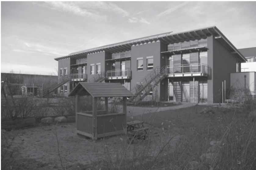
Auch in Arheilgen müssen die Betreuungsplätze für unter-dreijährige ausgebaut werden. Im Bild die Kindertagesstätte „Kinderhaus Sonnenblume“ im Asternweg im Blumenviertel.
