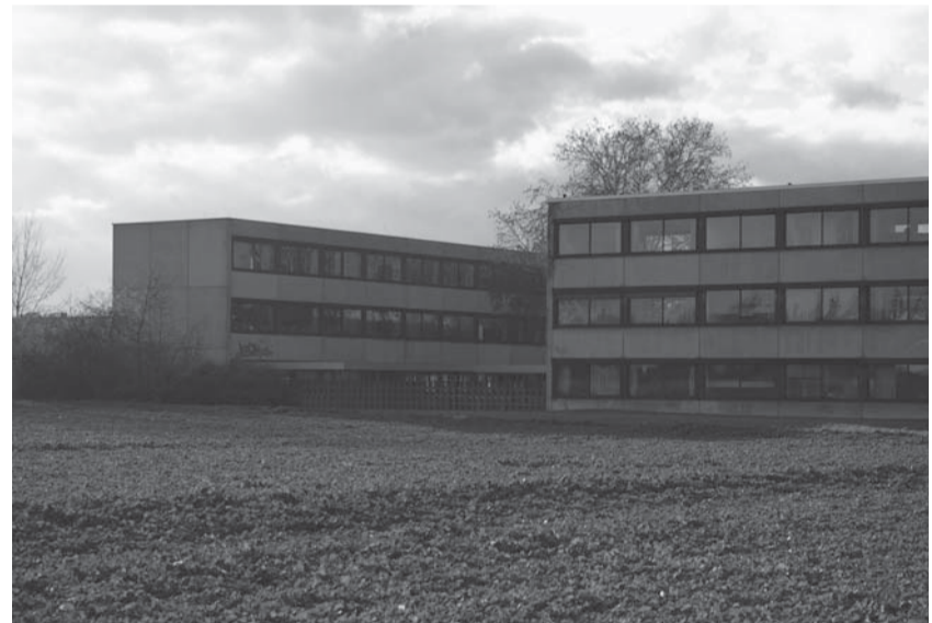
Die Stadtteilschule soll zur Ganztagschule ausgebaut werden.
