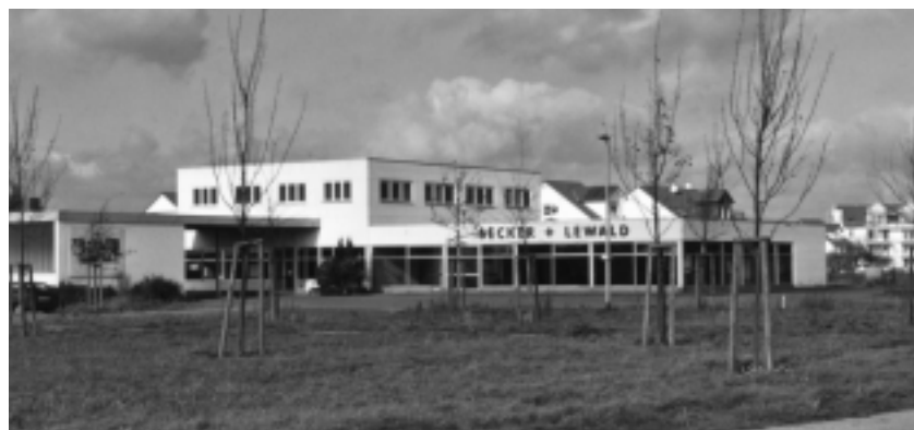
Auf dem Gelände des ehemaligen Autohauses Becker+Lewald soll ein Aldi-Markt entstehen.
